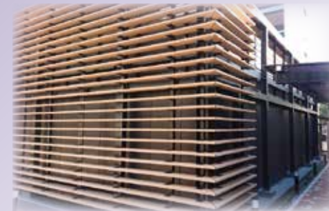
千葉県某ホテル(ルーバー)
