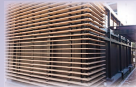
千葉県某ホテル(ルーバー)
