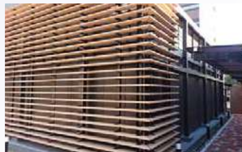
千葉県某ホテル ルーバー
